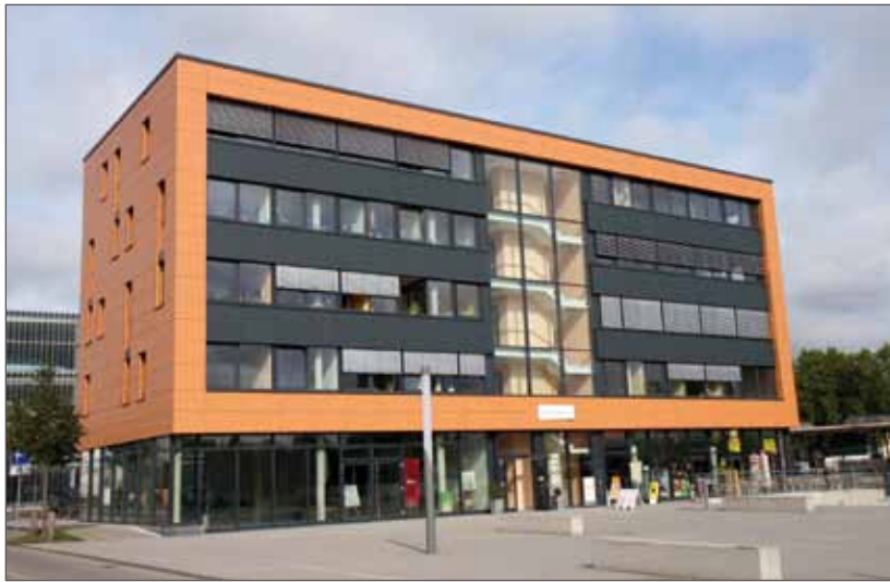
In diesem Geschäftshaus in Hennef wurde der eibPort als Bindeglied von EnOcean und KNX bereits installiert
